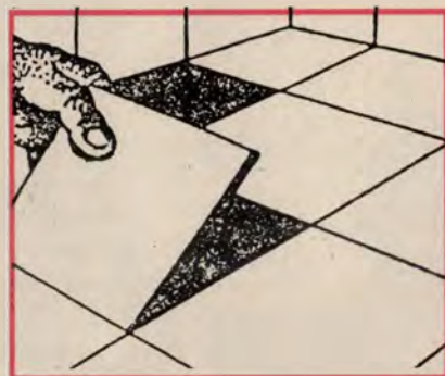
Burkolólap ragasztása
